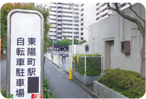
自転車駐車場を増設すべき【東陽町駅自転車駐車場】
