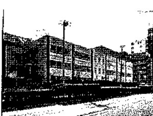
堀江小学校の改修工事 (令和3.2.26)
