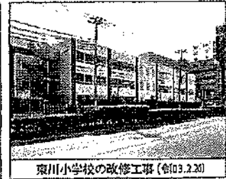
猿川小学校の改修工事(令和3.2.20)
