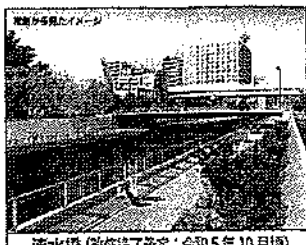
清水橋(改修完了予定:令和5年10月頃)
