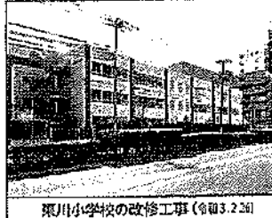
東川小学校の改修工事(令和3.2.26)
