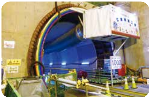
水害対策のための環境整備を【江東幹線工事の様子】
