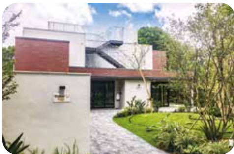
認証保育所の改築・改修に対する補助の実施を【認証保育所】
