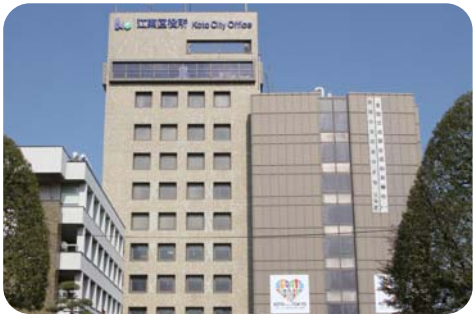
庁舎の改築について本格的に検討すべき 【区役所本庁舎】
