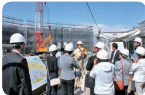
有明西学園の新築工事を視察【文教委員会】
