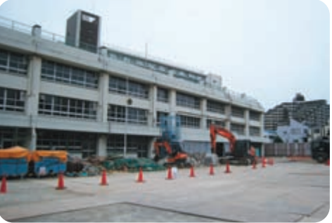
大規模改修が進む学校施設 【区立小学校】
