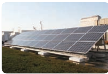
進む太陽光発電施設の整備 【防災センター屋上太陽光パネル】
