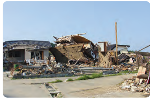
木造住宅の耐震化助成の推進を 【木造住宅倒壊の様子 (イメージ写真)】
