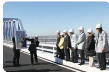
工事中の東京湾臨海道路(東京ゲートブリッジ)を視察 (清掃港湾・臨海部対策特別委員会)
