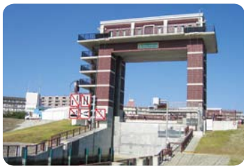
荒川ロックゲート
