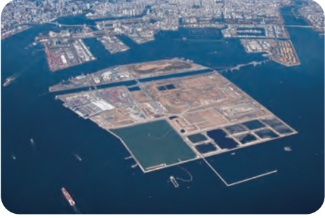
区民の夢のある場所としての利活用を【中央防波堤埋立地】
