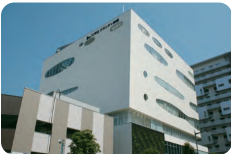
城東地区にも多世代交流施設の建設を 【グランチャ東翼】
