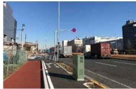
臨港道路の無電柱化
