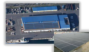
太陽光パネルの整備
