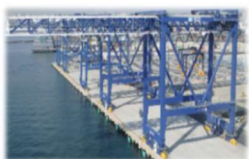
耐震強化岸壁・免震クレーン
