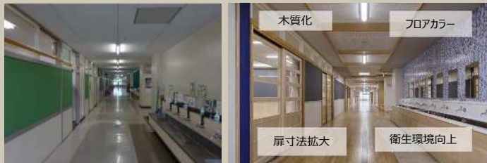
長寿命化改修の改修前後の様子
