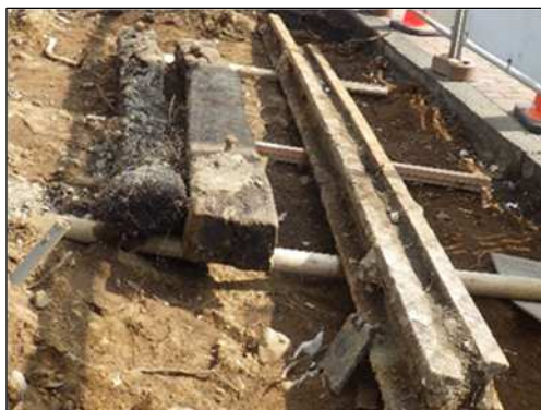
地中障害物の除去（アスファルト）
