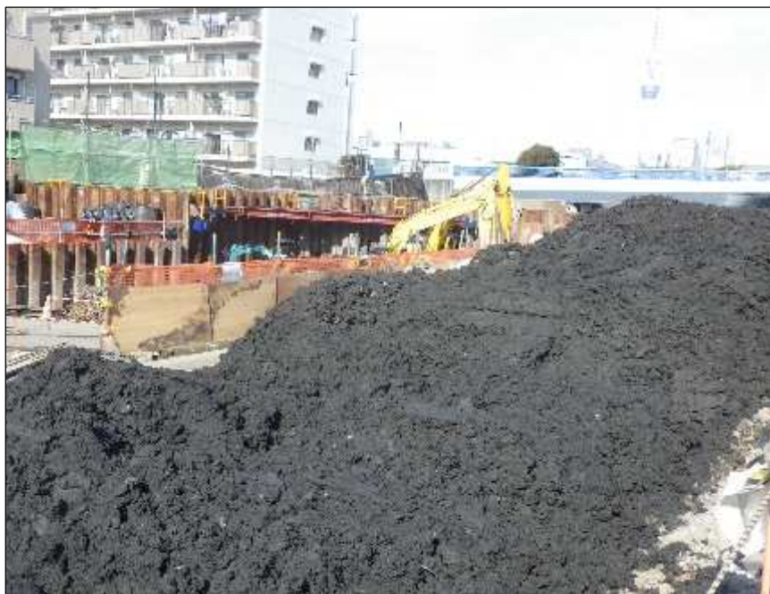
汚泥の掘削状況
