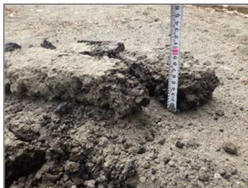
地中障害物の除去（アスファルト）
