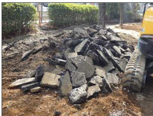
地中障害物の除去（アスファルト）
