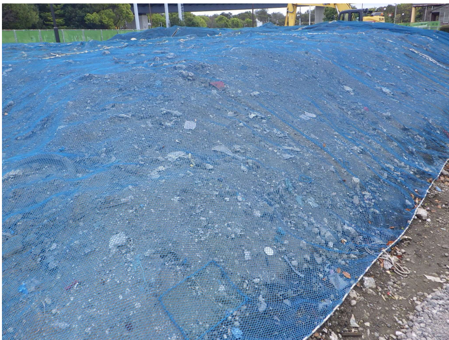
全景（一時保管状況）
