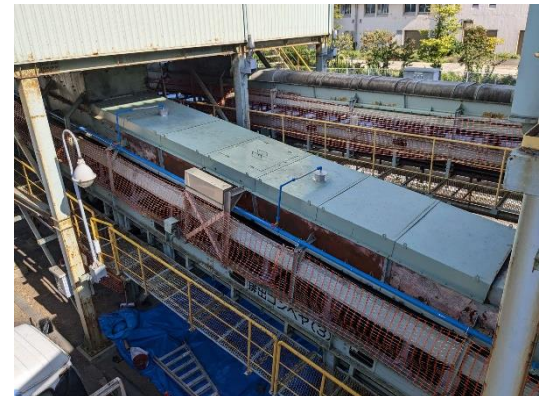
コンベヤベルト（復旧後）
