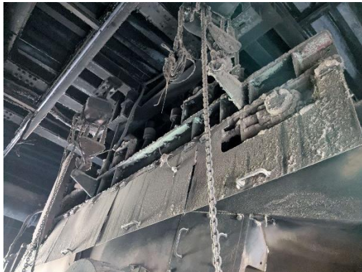
磁選機（復旧前）
