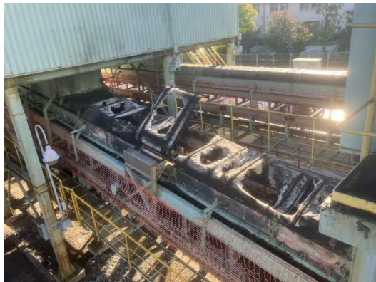
コンベヤベルト（復旧前）
