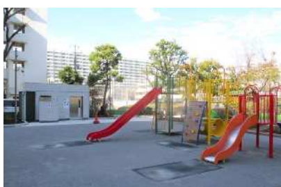
公園改修（大島四丁目）
