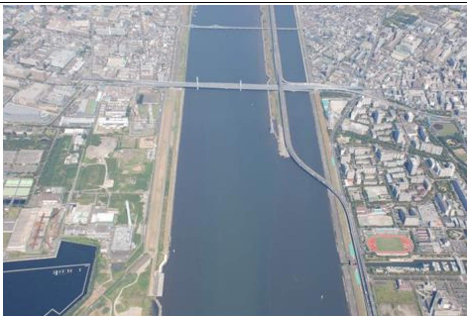
新砂ブロック付近の荒川（0km 付近）
