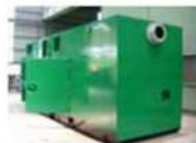
非常用発電機
