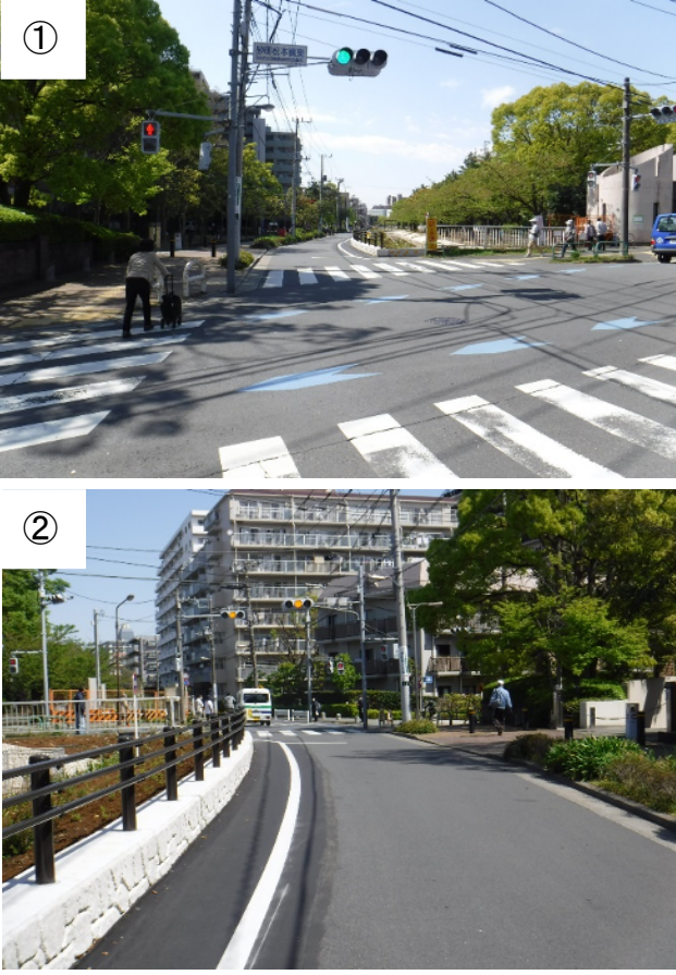
2 現況写真（「砂町松本橋東」交差点付近）
