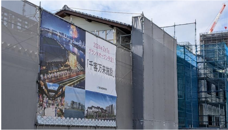
<開業予定日を周知する看板（建設現場）>
