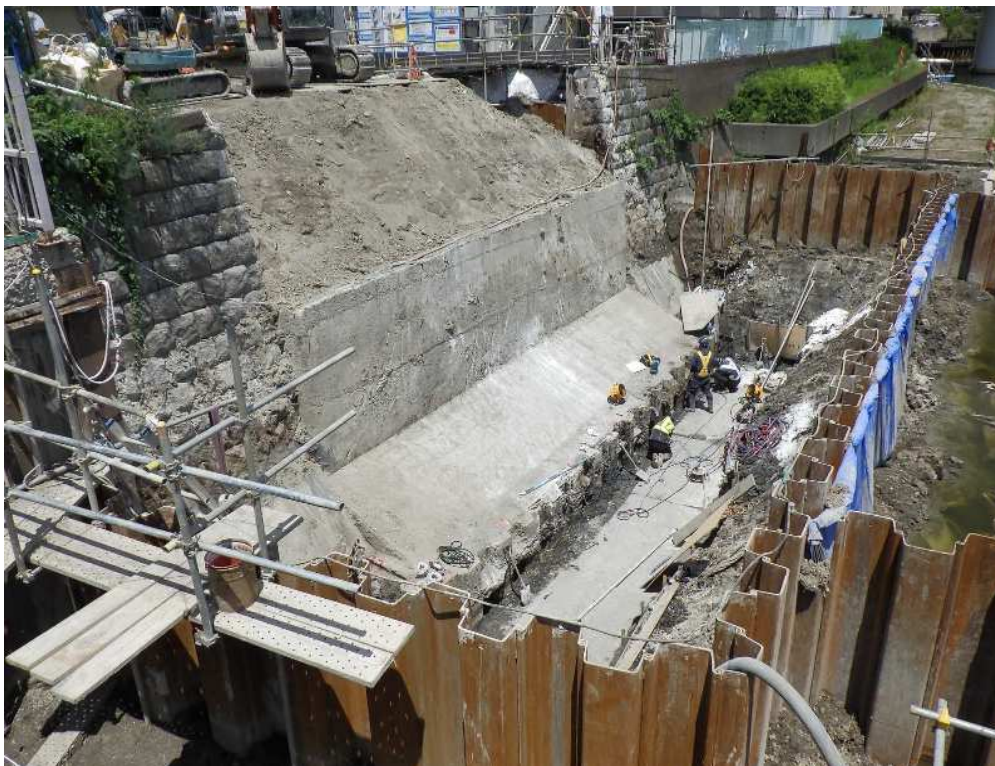
橋台フーチング部切削前
