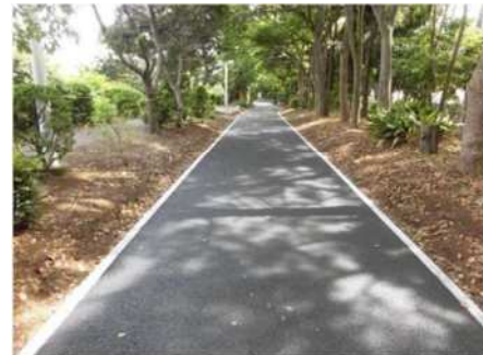
海上公園内サイクリングルートの整備
