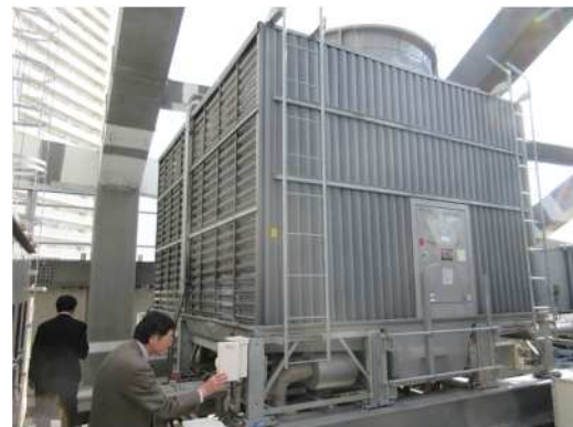
豊洲シビックセンターにおける省エネ診断(実地調査)
