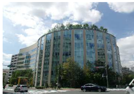
優良緑化事例（江東リハビリテーション病院）
