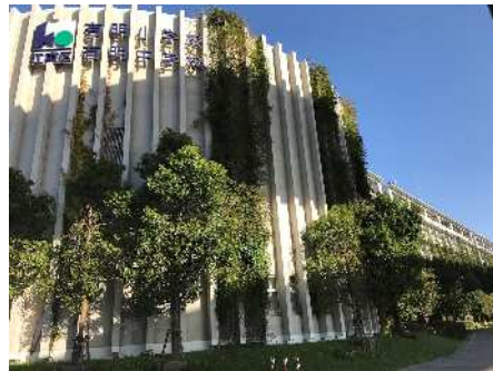
有明小学校・中学校の壁面緑化
