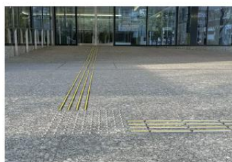
点字・誘導ブロック
