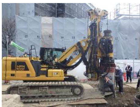
地中障害物撤去状況
