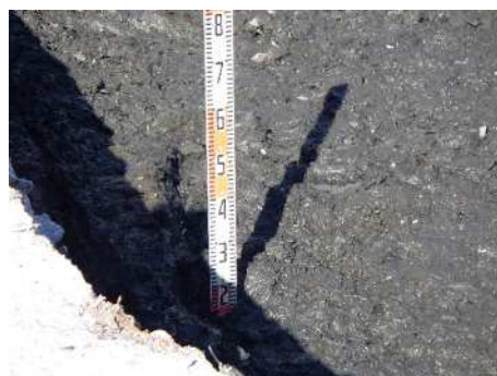
汚泥堆積状況(近景)
