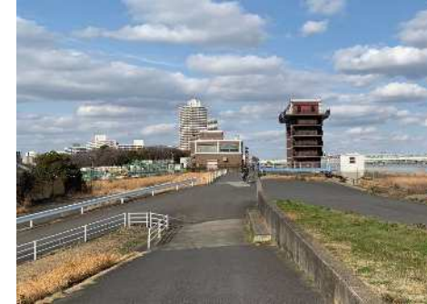
江東区側から見た荒川ロックゲート
