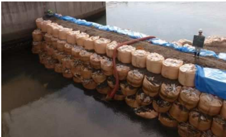
大型土のうによる止水イメージ
