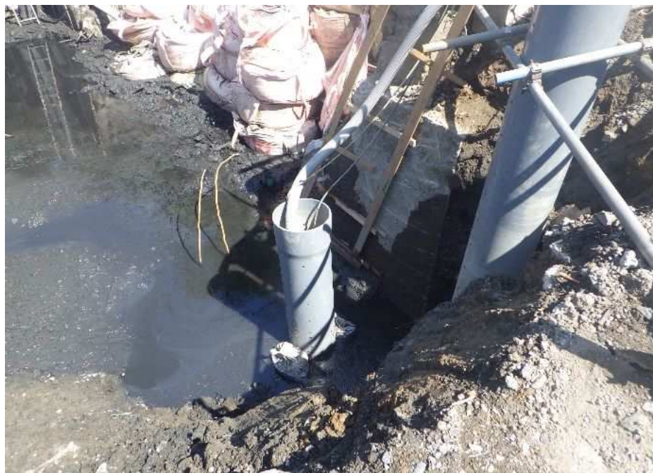
地下水の仮排水
