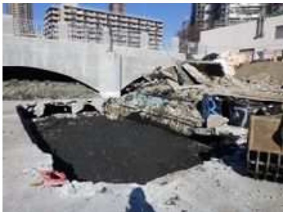
暗渠内の汚泥
