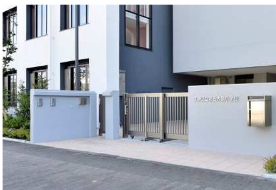
セキュリティに配慮した正門
