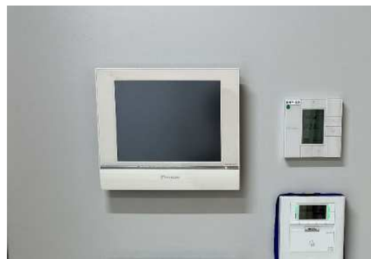
電気錠・インターホンの設置
