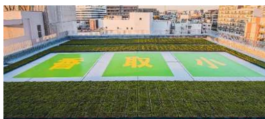
屋上緑化とヘリサイン
