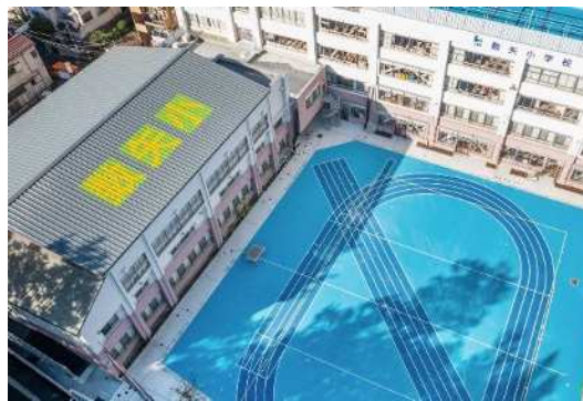
体育館屋根のヘリサイン
