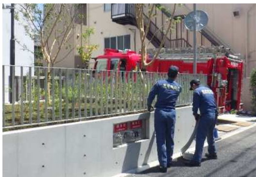
消防水利の設置
