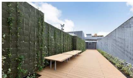
屋上施設の緑化
