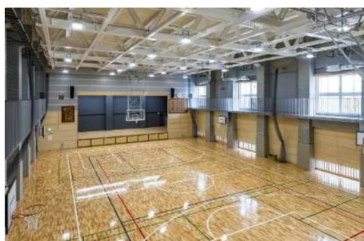
非浸水階に設置した体育館
