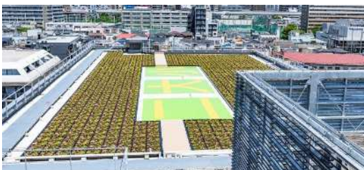
建築物上の緑化とヘリサイン
