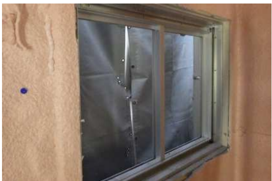
断熱材の設置
