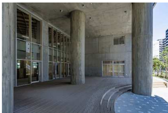
2層の高さのある軒下空間
