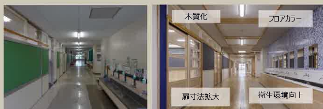
長寿命化改修の改修前後の様子
