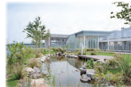
5. 質の高い魅力ある緑化・地域の生物多様性への配慮(屋上緑化とポケットエコスペース)
