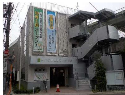
亀戸駅東口自転車駐車場
