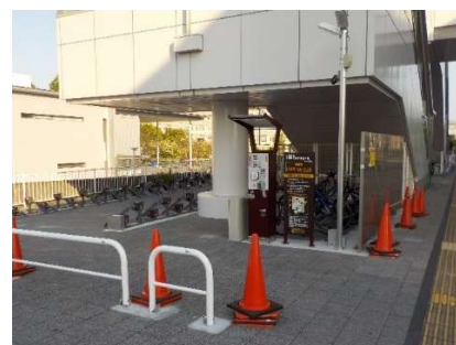
有明駅自転車駐車場
