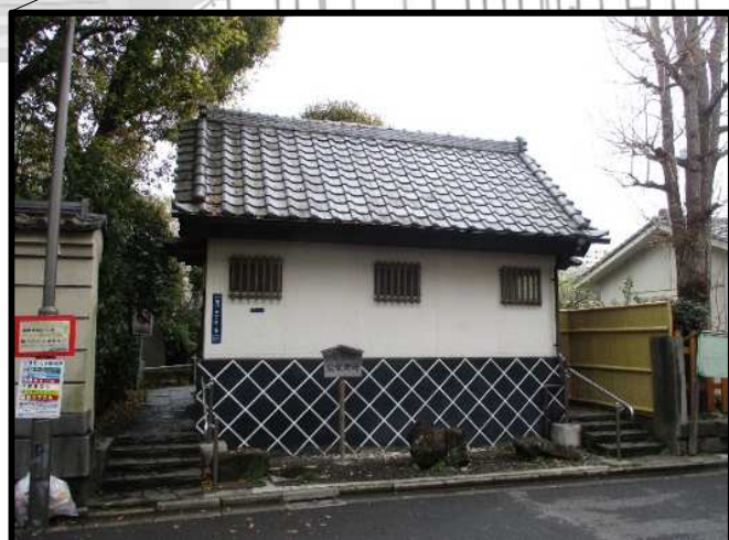
既存の公衆便所
