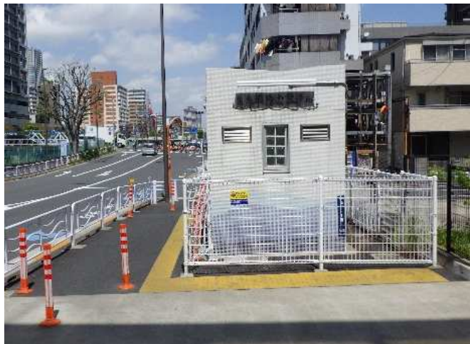
既存の公衆便所
