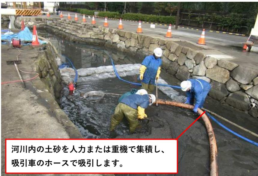
河川内の土砂を人力または重機で集積し、吸引車のホースで吸引します。
