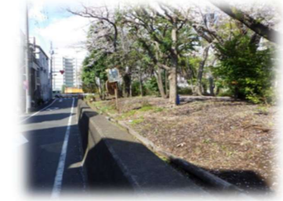
現 況（東側区道の護岸）
