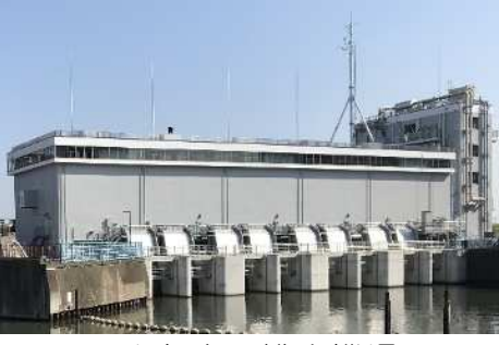
小名木川排水機場
