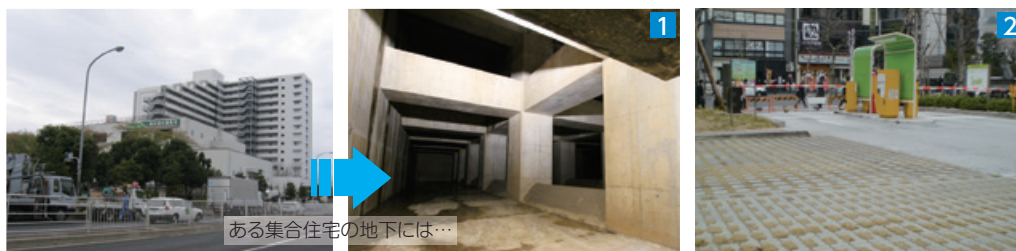
①【都下水道局 南砂雨水調整池】・下水道管からの雨水を貯留する施設で、貯留量は25,000t（小学校プールで約110杯分） ②【江東区役所 緑化駐車場】・緑化ブロック・透水性舗装の整備により、雨水を地中に分散・浸透しています。
