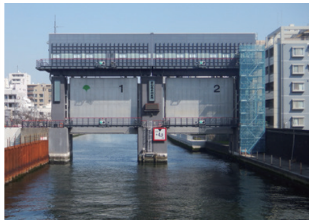
隅田川に面した5つの水門の水位の基準となる新小名木川水門。
