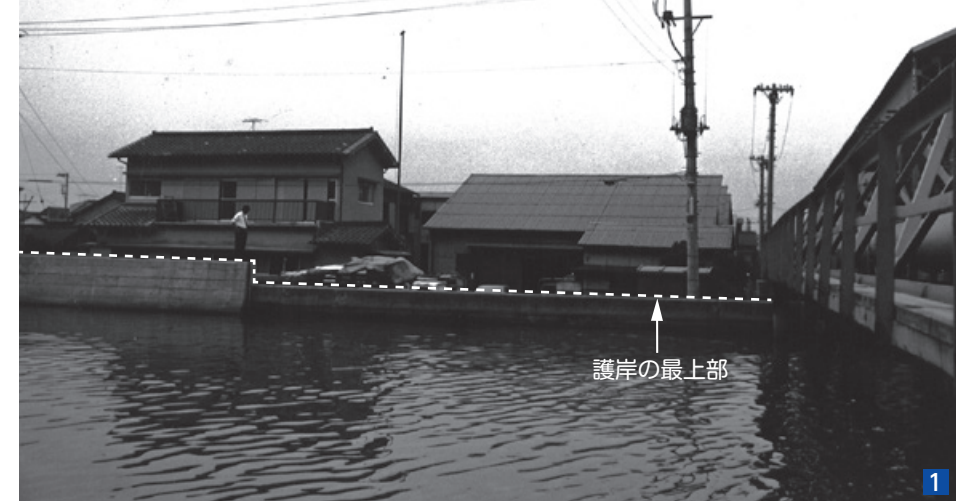
① 満潮時、護岸の天端近くまで水が迫る小名木川。左側はかさ上げした新護岸。昭和45(1970)年9月30日 ② かつてのかさ上げ護岸が確認できる場所 小名木川(北砂5丁目) ③ 小名木川(北砂6丁目)「護岸かさ上工事の歩み」
