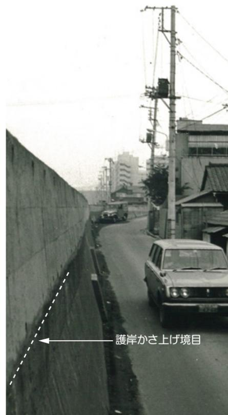
地盤沈下によりかさ上げた小名木川の護岸。昭和45(1970)年9月30日 北砂6丁目
