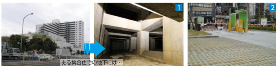
①【都下水道局 南砂雨水調整池】・下水道管からの雨水を貯留する施設で、貯留量は25,000t(小学校プールで約110杯分)
