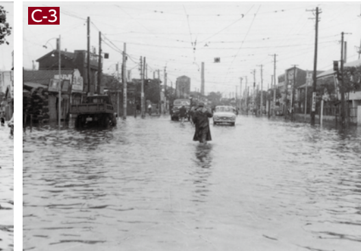
京葉道路(亀戸6丁目付近)
