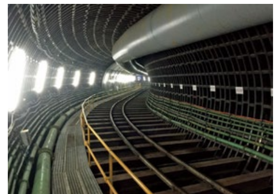
【東大島幹線・南大島幹線工事】
