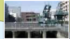
清澄排水機場(清澄1丁目)
