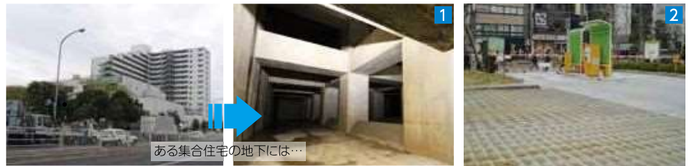
①【都下水道局 南砂雨水調整池】 ・下水道管からの雨水を貯留する施設で、貯留量は25,000t (小学校プールで約110杯分) ②【江東区役所 緑化駐車場】 ・緑化ブロック・透水性舗装の整備により、雨水を地中に分散・浸透しています。
