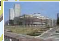
防潮堤 春海橋公園(豊洲2丁目)
