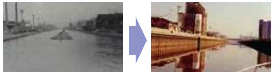
満潮時、護岸天端付近まで水位がある内水位低下前の小名木川（昭和45年9月30日） 第一次内水位低下によってA.P.±0mまで下がった扇橋樋門より東側の小名木川（昭和53年12月実施）
