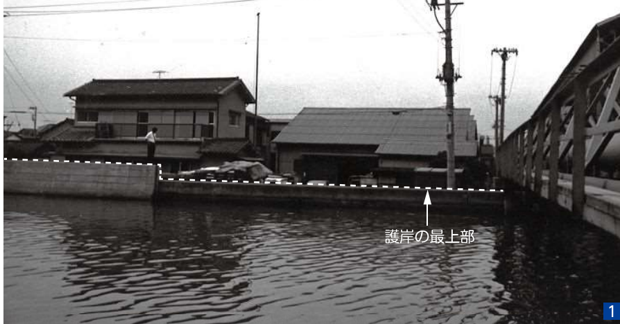
① 満潮時、護岸の天端近くまで水が迫る小名木川。左側はかさ上げした新護岸。昭和45(1970)年9月30日 ② かつてのかさ上げ護岸が確認できる場所 小名木川(北砂5丁目) ③ 小名木川(北砂6丁目)「護岸かさ上げ工事の歩み」
