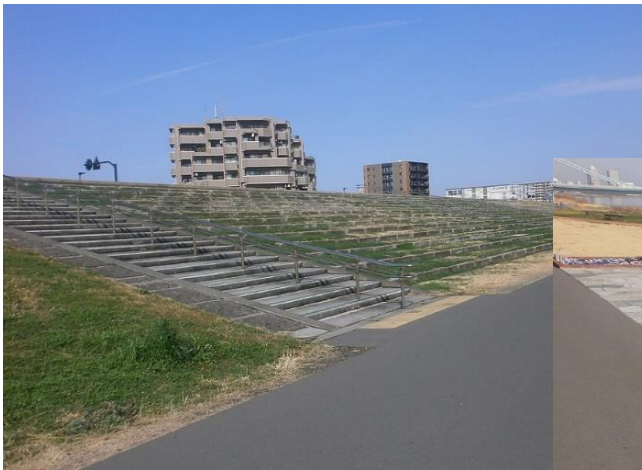
堤防の緩傾斜化及び緑化
