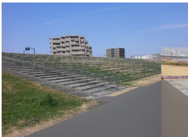
堤防の緩傾斜化及び緑化
