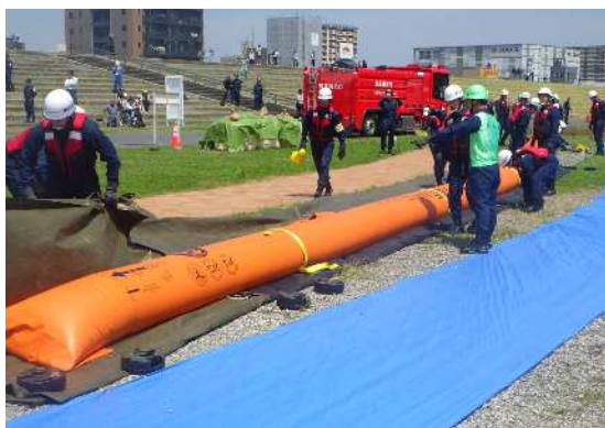
作業中の様子
