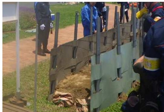
作業後の様子
