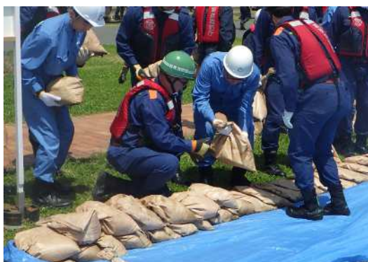
作業中の様子
