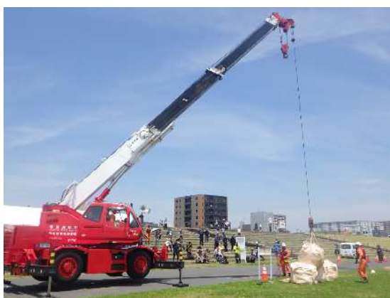
作業中の様子
