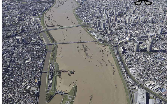
令和元年19号台风经过后的荒川（北区、岩渊水闸附近10月13日13时约A.P.+7.01m（较泛滥水位低约70cm）
